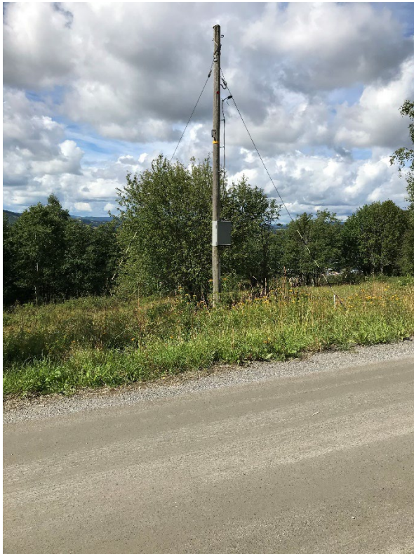
Korte barduner. Foto: Statens kartverk
